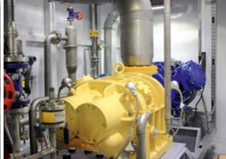
Модуль ДКС для попутного нефтяного газа. Вид внутри контейнера. Восточно-Таркосалинское месторождение.
