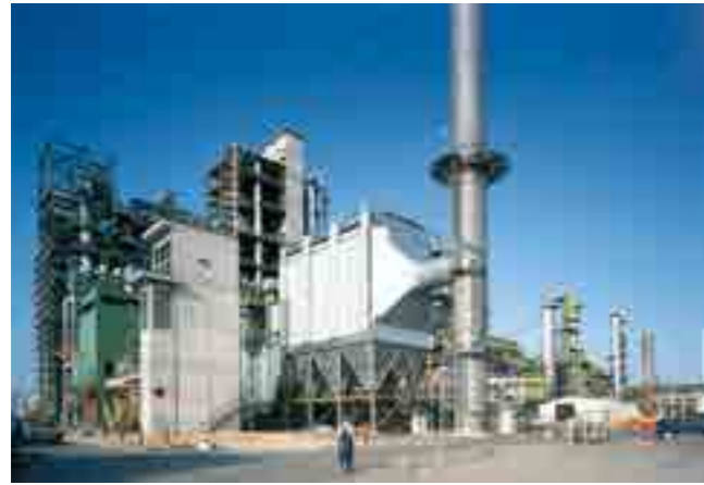
Установка 3-польного электрофильтра...
