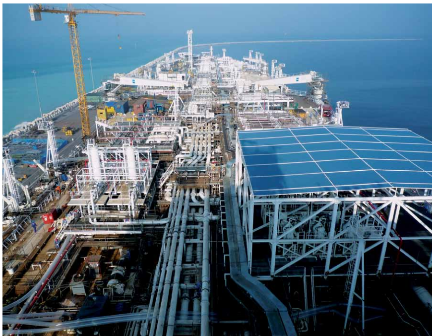
Рис. 3. Плавающая установка для добычи, хранения и отгрузки нефти Peng Bo (Hai Yang Shi You 117, Bohai Bay) FPSO, месторождение Peng Lai. Сепарационные блок-модули на базе сепараторов ODB 260
